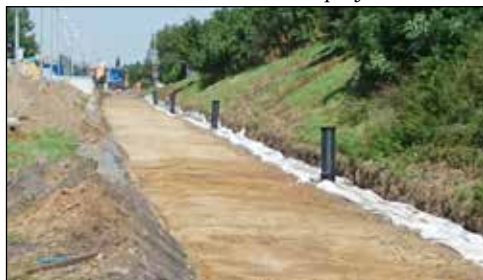
Kompletní výměna štiřkového lože a železničního svršku v žst. Kunovice zastávka.
