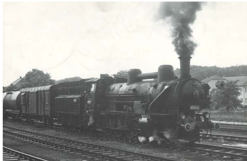
Železniční stanice Střelice a lokomotiva 434.2134 na vlaku Mn 84329. Na snímku z roku 1977 je mezi kolejemi č. 3 a 5 vidět i betonová plocha s rýhovaným plechem nepravidelného tvaru. Zde měl být vodní jeřáb, který ovšem nikdy nebyl postaven. Foto: ing. Bohumil Skála
