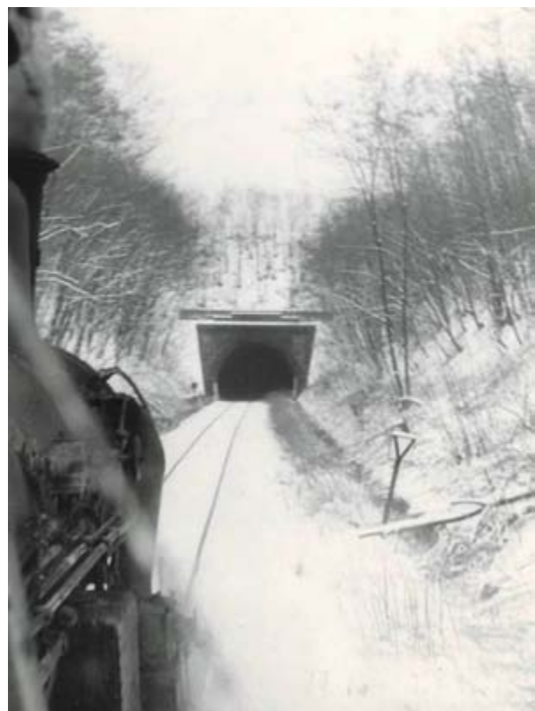
Tunel Velký Prštický z pohledu strojvedoucího lokomotivy 434.2134 (foto ze sbírky Zdeňka Hájka)
