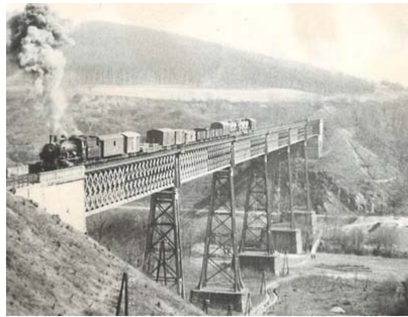
Mn vlak jedoucí po viaduktu ve směru na Hrušovany nad Jevišovkou. Z tohoto obrázku je zřejmé, že se tak děje v době, kdy již byly odstraněny dřeviny v místech, kde bude stát nová mostní konstrukce. Její stavba započala v roce 1972 (foto ze sbírky Zdeňka Hájka)
