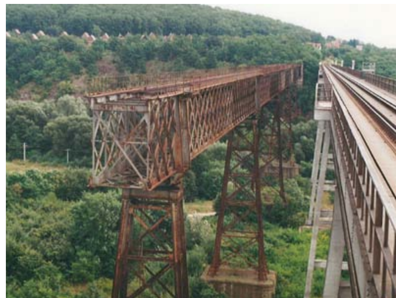
Ještě poměrně rozsáhlé torzo starého viaduktu je vidět na levé straně tohoto záběru, který byl pořízen z nové mostní konstrukce. Fotografie ze sbírky Zdeňka Hájka pochází z období někdy mezi lety 1992 až 1998. Již v roce 1991 bylo demontováno první pole staré mostní konstrukce na krumlovské straně. V roce 1999 se to ale týkalo už takřka celého mostu, tedy až na jeho jedno pole a jediný mostní pilíř
