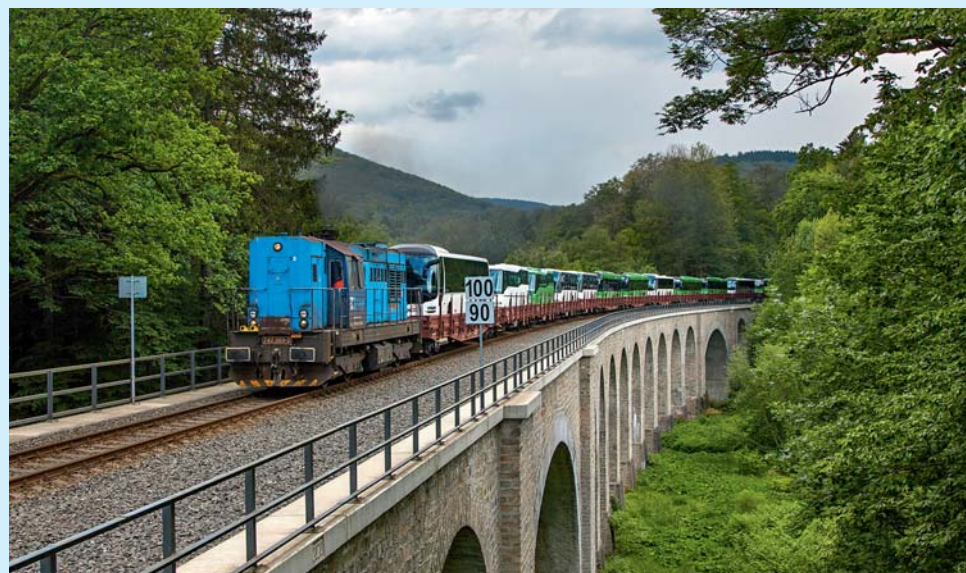
Lokomotiva 742.369 v čele manipulačního vlaku Mn 84041, jehož zátěž tvořilo 31. května 2024 celkem 12 železničních vozů ložených autobusy. Snímek byl pořízen na 238 metrů dlouhém machnínském viaduktu, který byl vystavěn jako dvoukolejný, ale k položení druhé koleje nikdy nedošlo. FOTO: TOMÁŠ SLUKA
