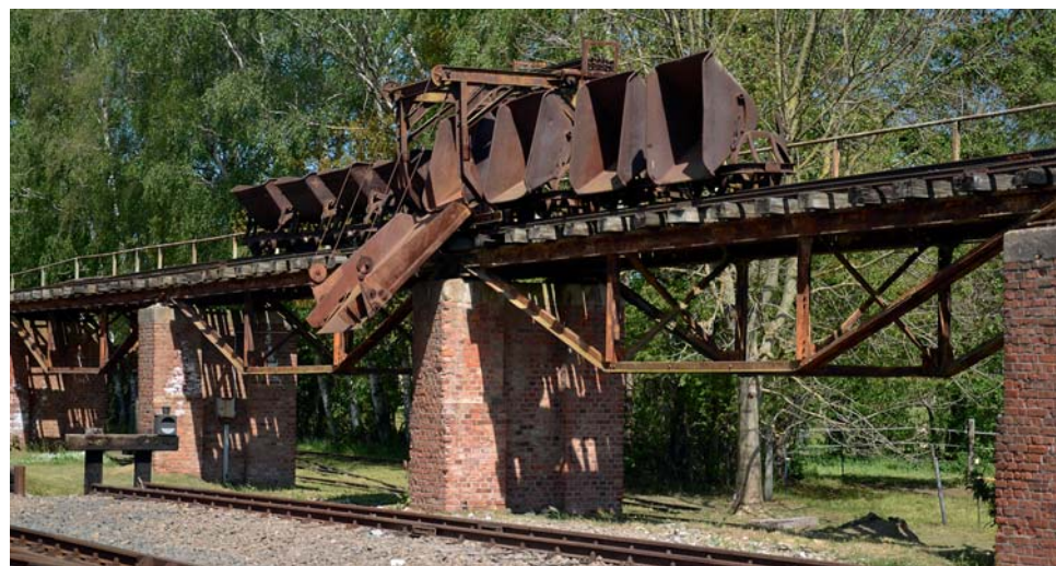
Rampa na překládku kaolinu z vozíků úzkorozchodné důlní dráhy v dopravně Glossen
