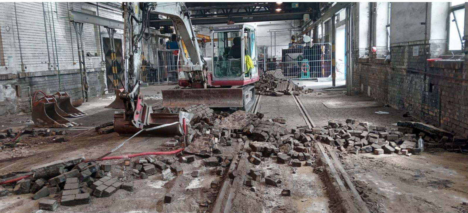
Rekonstrukce betonové podlahy
