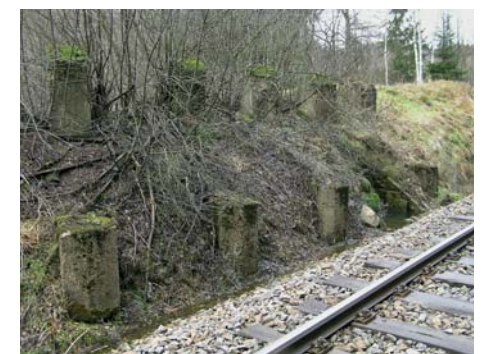
Pozůstatků po nákladních lanovkách se do dnešních dnů příliš nedochovalo. Zbytky základů ochranného mostu nad železniční tratí u zastávky Vysoká Pec na Karlovarsku. Zdejší lanovka sloužila pro přepravu kalů z úpravny uranové rudy na skládku.
