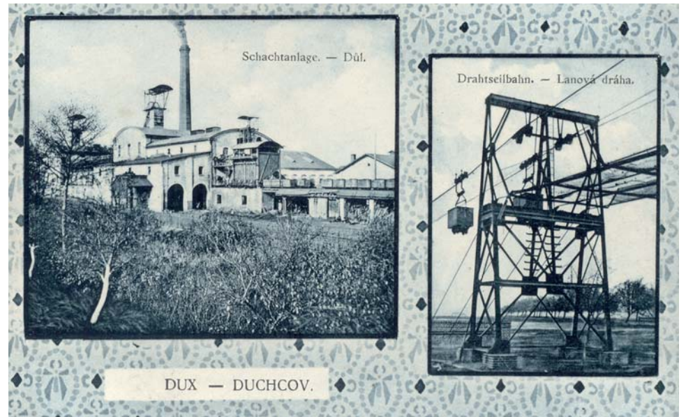
Nákladní lanová dráha na přepravu uhlí v Duchcově
