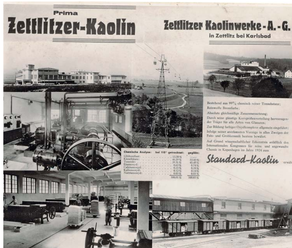
Na propagačním materiálu Sedleckých kaolinových závodů můžeme vidět nejen výrobní závody této firmy, ale i železné podpěry na trase lanové dráhy z Ústřední stanice do plavírny v Sadově a v pravém dolním rohu i železniční vlečku a detail Ústřední stanice lanových drah u dolu Excelsior
