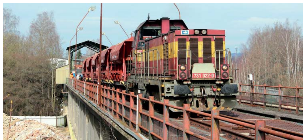
Výsypný železniční most na vlečce odbočující ze stanice Jihlava město slouží jak pro překládku písku, tak pro vykládku uhlí pro místní uhelné sklady firmy START Zelený s.r.o. O areál mělo zájem město, které zde chtělo postavit byty. To se naštěstí nestalo a za velké podpory majitele firmy pana Zeleného, se vlečka opět probudila k životu. FOTO: TOMÁŠ ZAPLETAL
