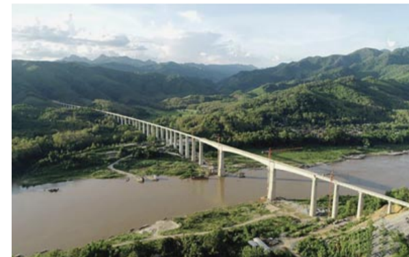
Letecký snímek rozestavěného mostu na trati spojující Vientiane s Čínou (červenec 2020)
