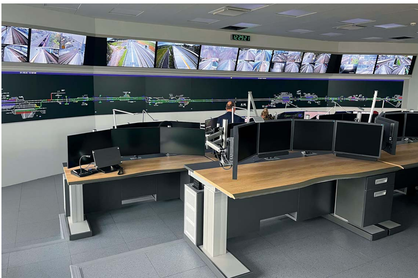
Pohled do jednoho ze sálů CDP Praha FOTO: ARCHIV SPRÁVY ŽELEZNIC
