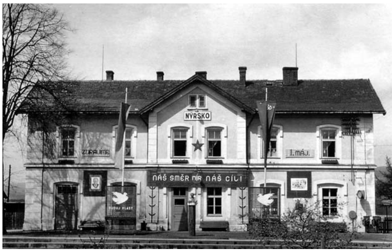
Stanice Nýrsko vyzdobená budovatelskými nápisy
