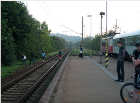
Zastávka Brno-Řečkovice: příklad trespassingu (na jedné ze zkratk) přes kolej č. 1 před rekonstrukcí (2015)
