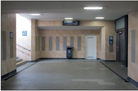
Karviná hl. n. po rekonstrukci: zřejmé neprodloužení podchodu pod krajní dopravní koleji č. 3 do části Karviná-Staré Město, které by zde bylo naléhavě potřebné
