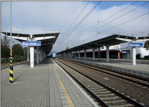
Stanice Karviná hl. n. po rekonstrukci: celkový pohled na opravená nástupiště a hlavní koleje č. 1 a 2
