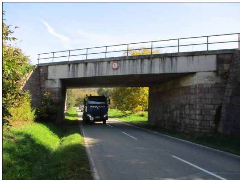
Bohuslavice u Kyjova: podjezd pod tratí po silnici II/432
