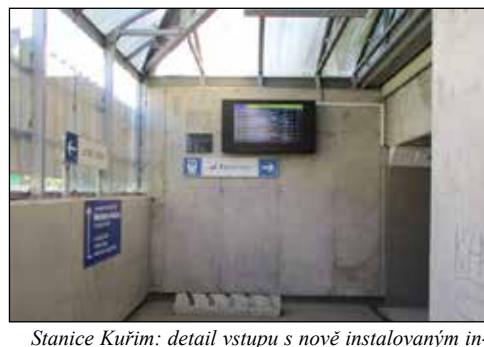
Stanice Kuřim: detail vstupu s nově instalovaným informačním systémem (po komplexní rekonstrukci stanice Kuřim provedené v letech 2017-2018)
