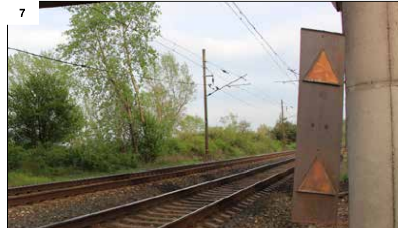
Zničené vzdálenostní upozorňovač III před vjezdem do žst Libice nad Cidlinou
