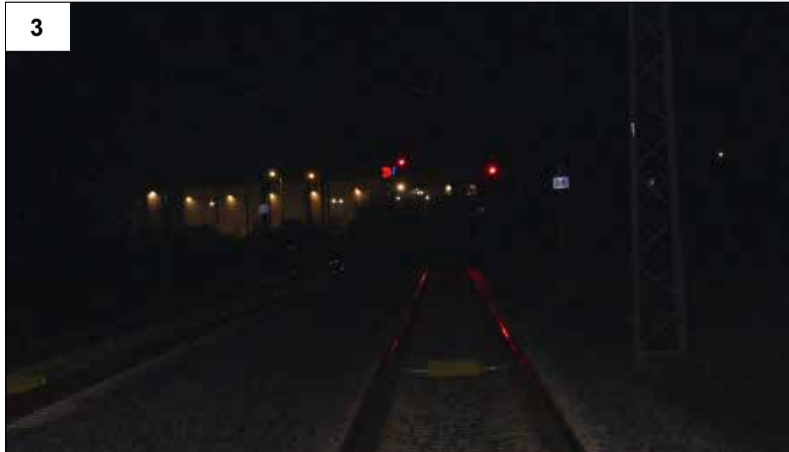
Cestová návěstidla Sc1c, Sc2c po sklopení svítidel průmyslového areálu Rosice
