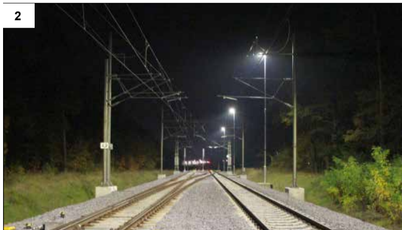
Zbytečně osvětlené stěblovské zhlaví žst Pardubice - Rosice nad Labem
