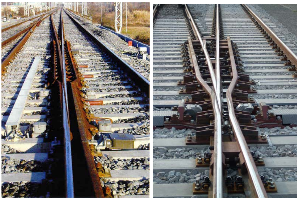
Obr. 23 – Jednoduchá srdcovka s pohyblivým hrotem
