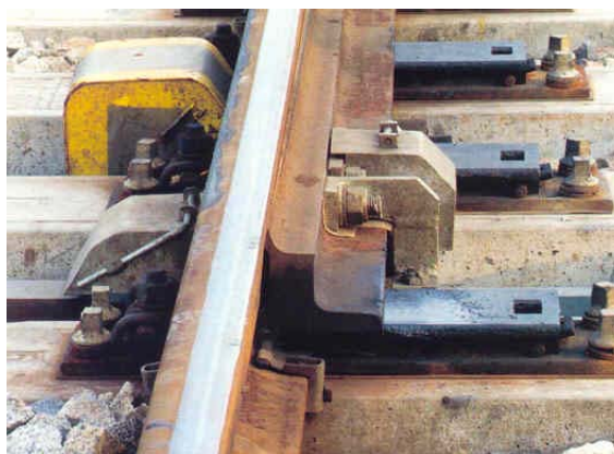
Obr. 33 – Pružné upevnění opornice v kluzných stoličkách typu Vossloh (převzato z katalogu DT výhybkárna a mostárna)
