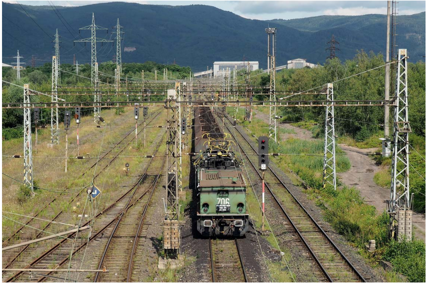
Poslední vlak ložený uhlím z lomu ČSA v čele s elektrickou odklizovou lokomotivou typu 27E. V pozadí v zalesněných svazích Krušných hor můžeme spatřit siluetu zámku Jezeří. FOTO: RADIM ŠNÁBL
