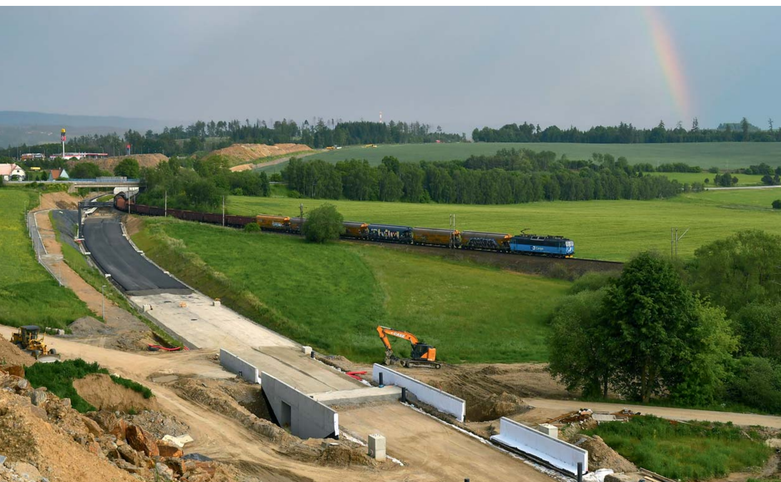
Výstavba nového úseku 4. tranzitního koridoru mezi Střezimířem a Meznem FOTO: LUKÁŠ STREJČ
